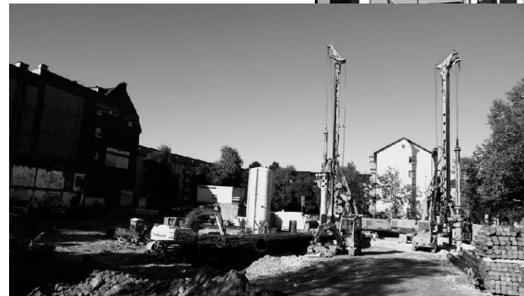
In der Silberhornstraße wird ebenfalls gebaut
