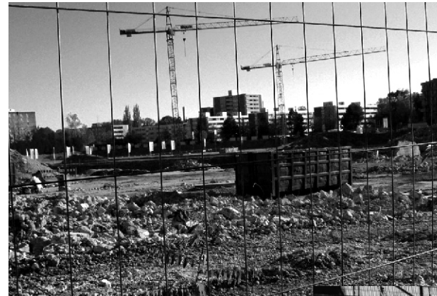
Das ehemalige Agfa-Gelände wird neu erschlossen
